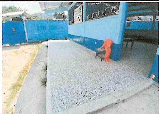
Foto 1: Sustitución de piso de granito por cerámico antideslizante (aula)
