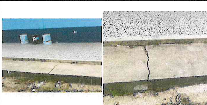
Foto 2: Reparación de banqueta (aula)
