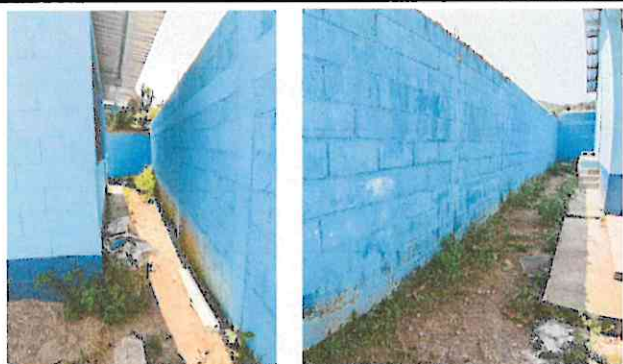
Foto 3: Implementación de cuneta de concreto (aula)
