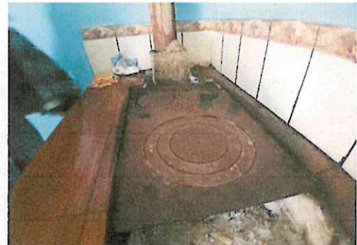
Foto 10: Sustitución de plancha de cocina por plancha fundida (cocina)
