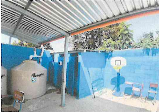
Foto 7: Implementación de depósito de agua para inodoro y lavamanos
