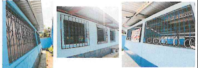
Foto 8: Implementación de ventanas de pvc (aulas)
