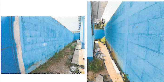
Foto 9: Implementación de repello y cernido de pared (tapial)
